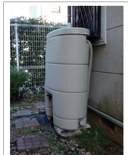
雨水貯留タンクの設置
