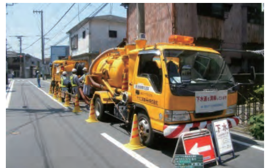
吸引車による下水道管の清掃
