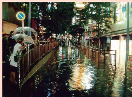
横浜駅西口の浸水被害 (2004(平成16)年10月)
