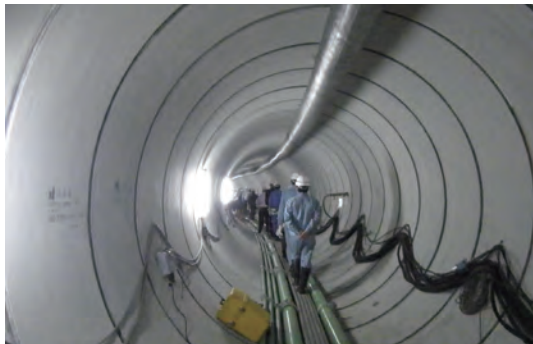
局所的大雨に対応する雨水幹線の整備
